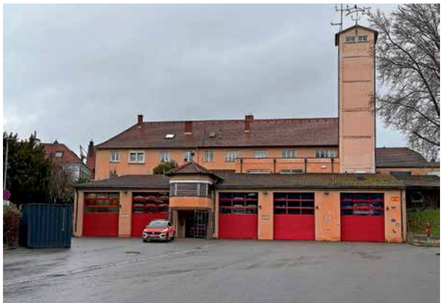
Das Feuerwehrgerätehaus an der Hauptstraße ist in die Jahre gekommen und platzt aus allen Nähten.
